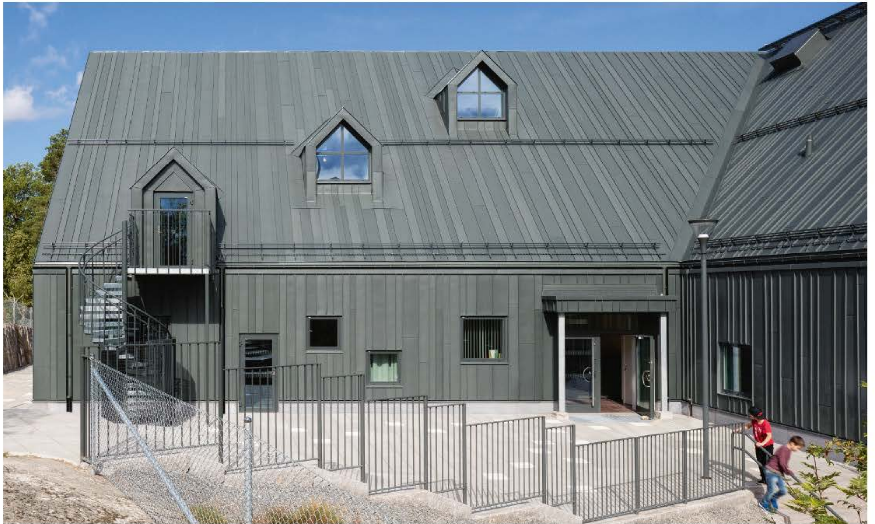
LÅNGBRODALSSKOLAN – PRIMARY SCHOOL · Älvsjö, Sweden
